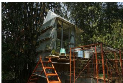
Gambar 9. Rumah Scaffolding-Studio Akanoma Bandung (Sumber : dokumen penulis, 2018)
